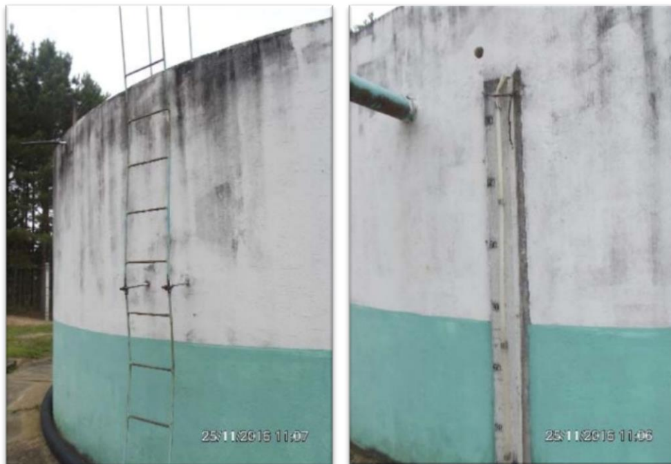
Figura 8. R01 - Escada e Mangueira de Nível
