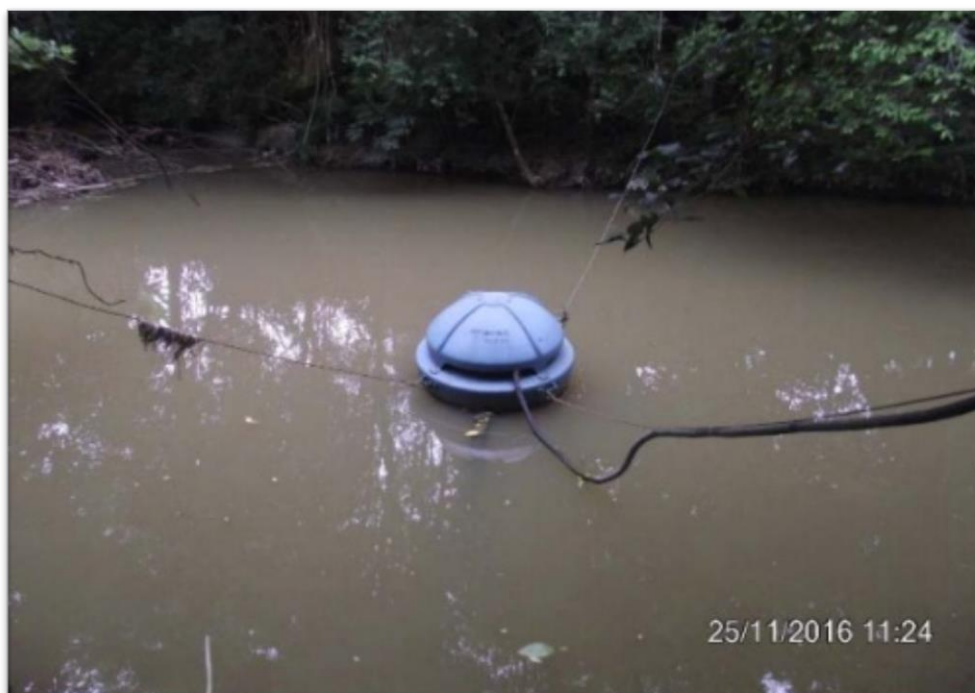
Figura 4. Bomba da captação.
