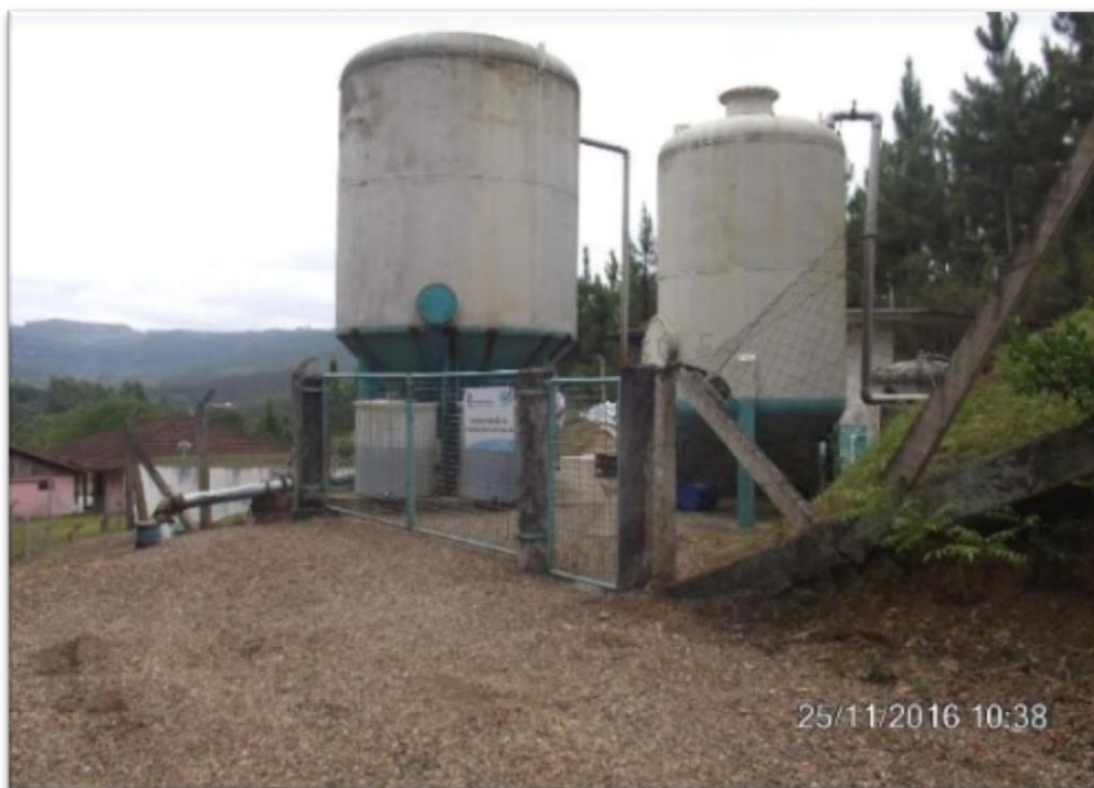
Figura 5. Entrada da ETA.
