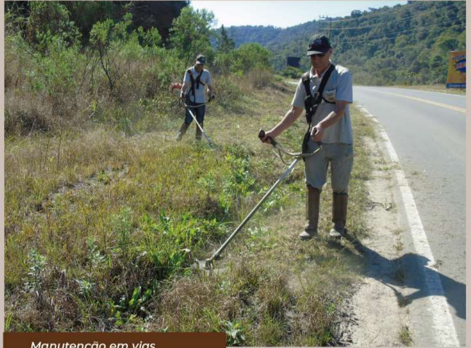
Manutenção em vias
