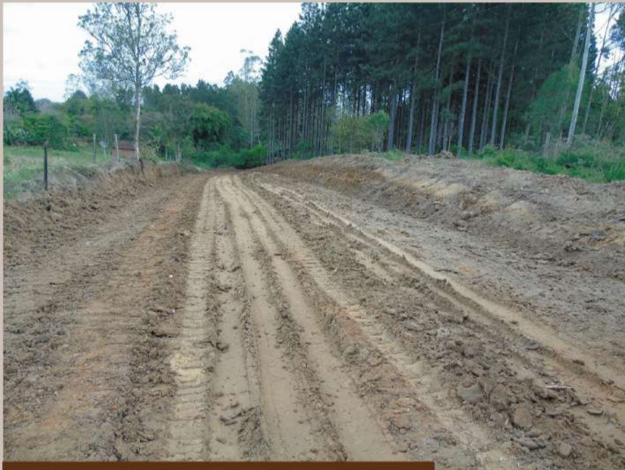
Alargamento de estrada na Serra do Urú
