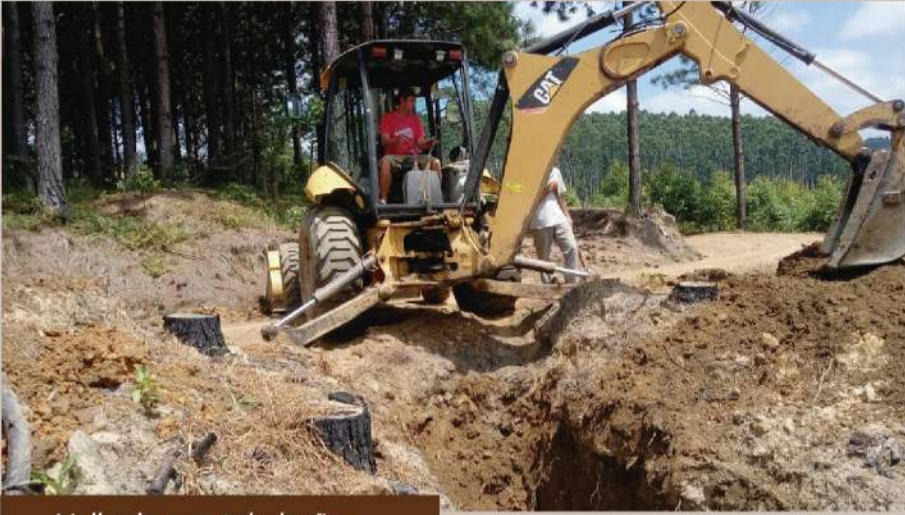
Melhoria com tubulações
